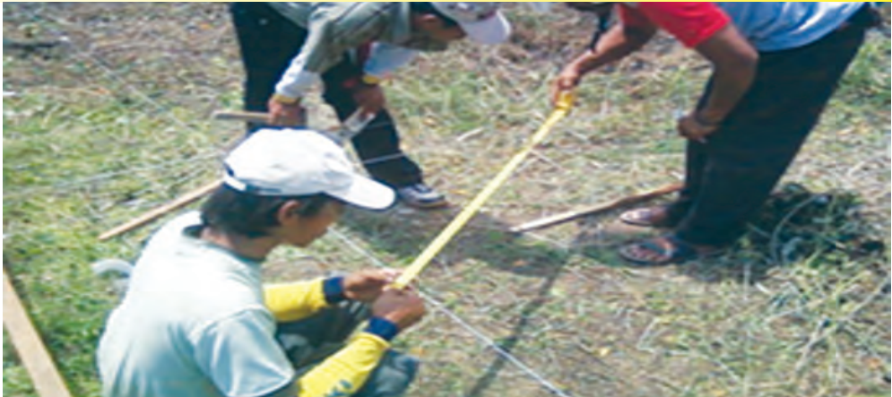
Gambar 6.1 Seorang Tukang sedang mengukur kesikuan lahan
