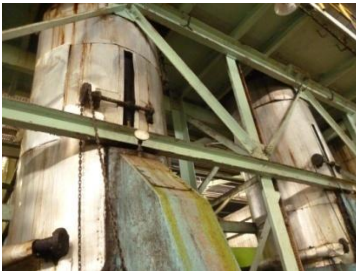
Gambar 22. Mesin Pengadukan ( digester )
